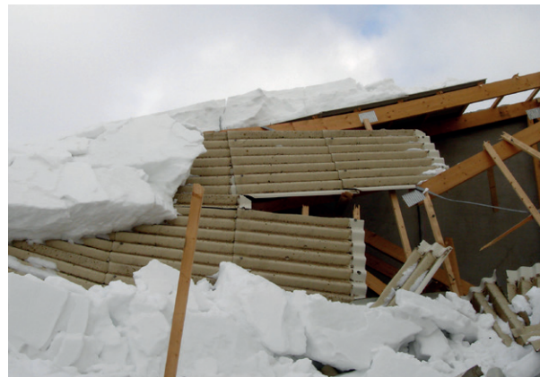
Figur 5 Kollaps efter sneophobning. Foto: BK NORD A/S.
