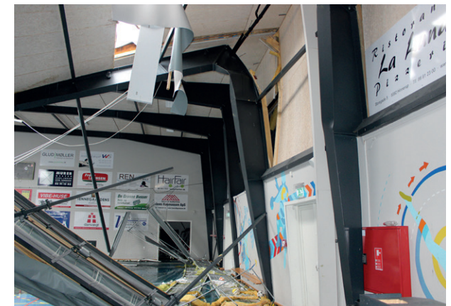
Figur 3 Stålrammehal med høj murkrone og lille taghældning. Stoppede afløb forårsagede vandophobning, da der ikke var nødafløb. Ophobningen udløste kollaps af to rammer.
