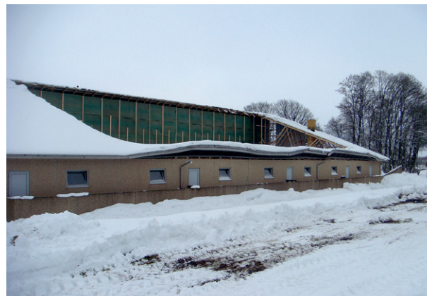
Figur 7 Kollaps efter sneophobning på stor tagflade. Foto: John Dalsgaard Sørensen.
